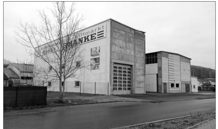
Bild 57: Die beiden ehemaligen Hallen des Heizwerkes in einer Aufnahme 2020 29)
